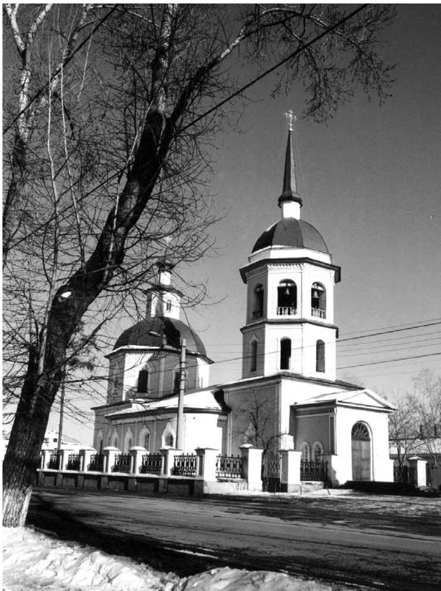
Преображенская церковь в Иркутске. Общий вид с северо-запада, март 2007
