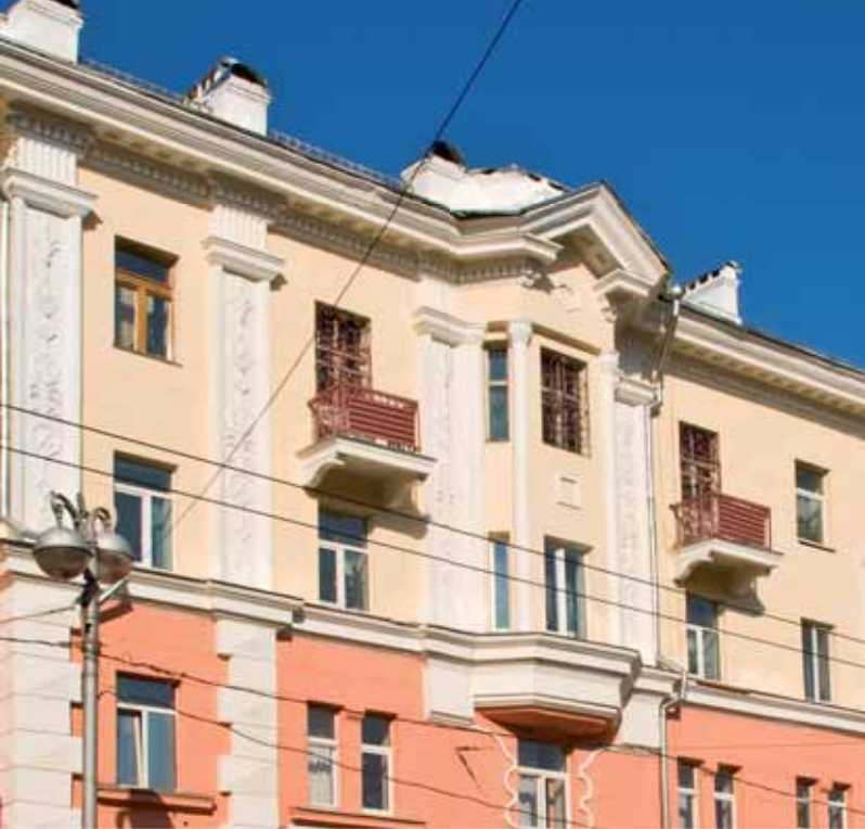
^ Фрагмент фасада жилого дома по ул. Ленина, 24
