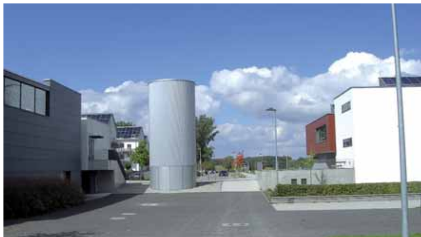
^ Накопитель тепла между зданиями спорт-зала и гимназии
