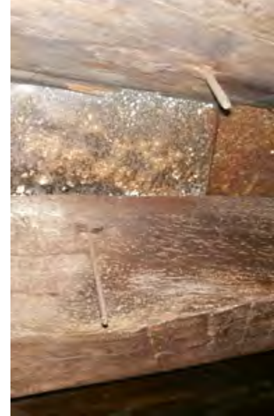
^ Рис. 10. Микологические обследования чердака, плесневые образования
