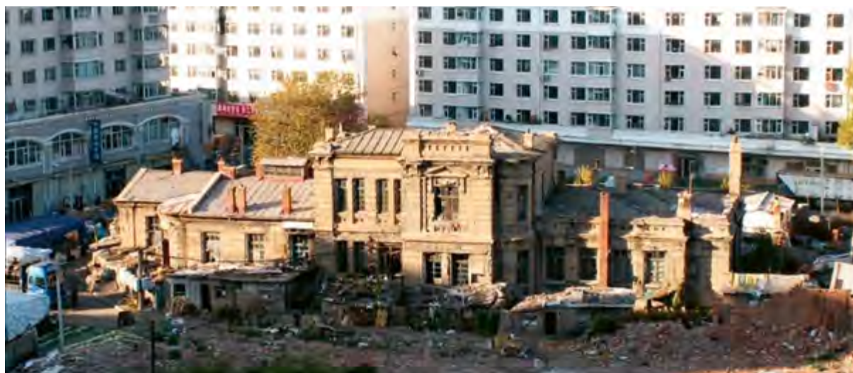
^ Рис. 12. Здание консульства перед реставрацией. 2008 ( https://www.quanjing.com/imgbuy/QJ8139276863.html )
