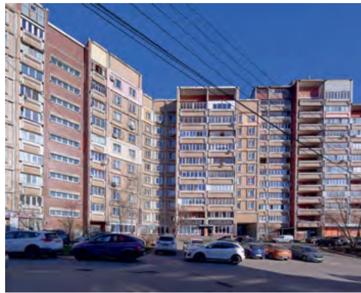
^ Рис. 12. Западные фасады секционных домов ЭЖК. Фото Н. Ю. Васильева 2023
