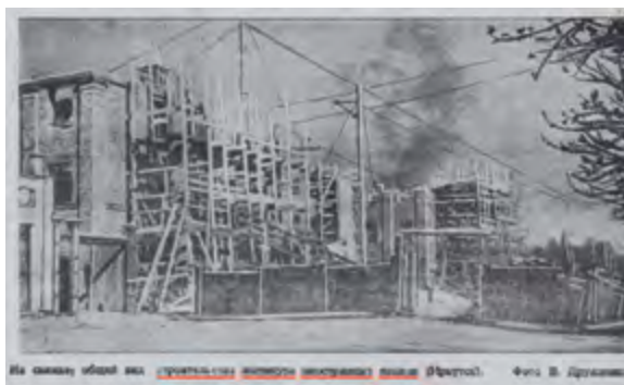
< Строительство здания Института иностранных языков (ул. Ленина, 8). Фото В. Дружинина. Советская молодежь, 1941, 30 мая
