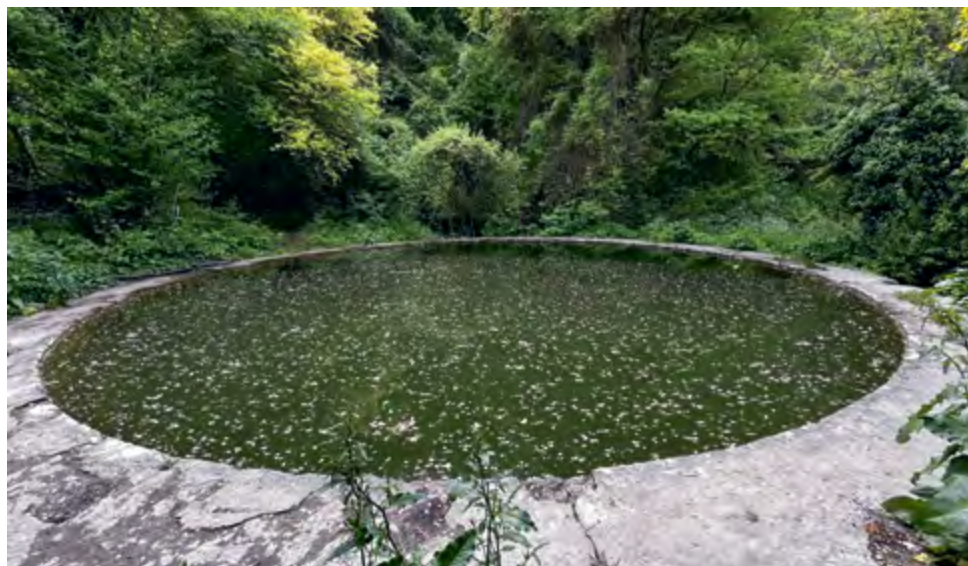
v Рис. 10. Элемент системы водовода усадьбы Кокораки – прекрасно сохранившийся бассейн-накопитель. Весна 2023 года
