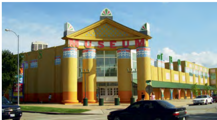
^ Рис. 5. Роберто Вентури. Детский музей, Хьюстон. Здание копирует надувную игрушку, которая имитирует классический фасад, раскрашенный в веселые желто-оранжевые тона. Вентури предлагал брать уроки у Лас-Вегаса, который заслуженно удерживает титул мировой столицы китча
