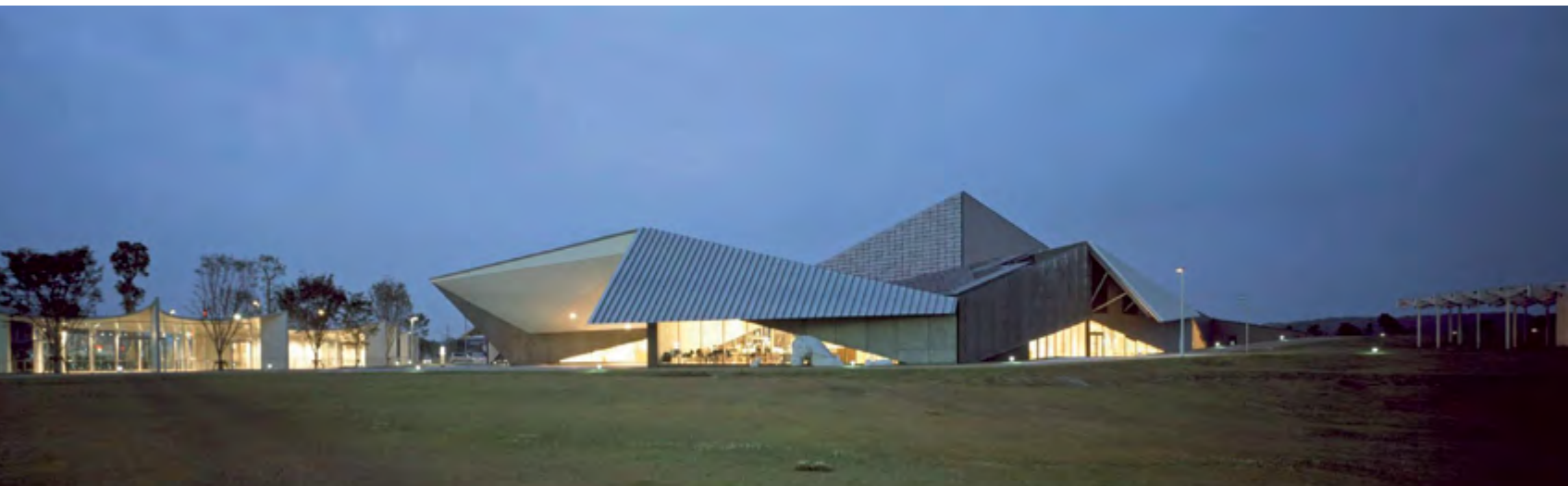
^ Рис. 21. Музей Кюсю Гэйбункан. Фуруока, Япония. 2013. Архитектор Кэнго Кума ( https://archi.ru )
