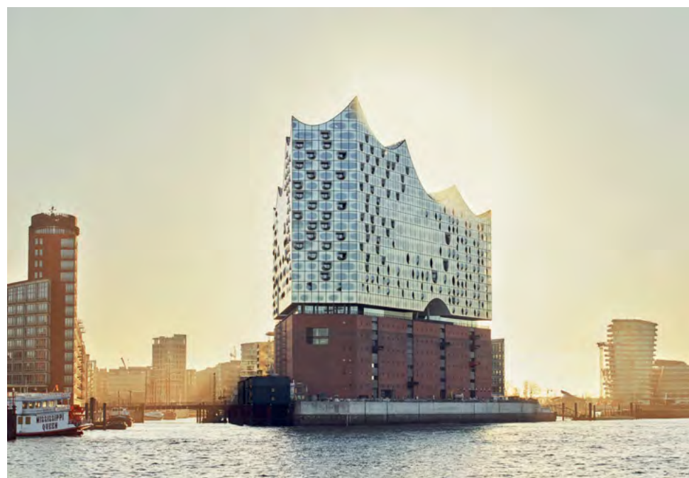
v Рис. 3. Гамбург (Германия). Эльбская филармония. Архитекторы Жак Херцог, Пьер де Мёрон. 2016 ( https://clck.ru/39UPvu )
