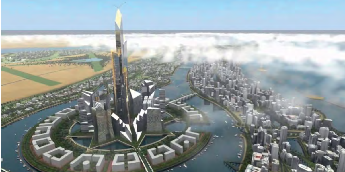
< Рис. 1. Проект башни Мубарак Аль-Кабир (г. Эль-Кувейт, Кувейт). Высота: 1001 м. Функция: Жилой/отель/офис. Дизайн: CivicArts/Eric R. Kuhne and Associates
