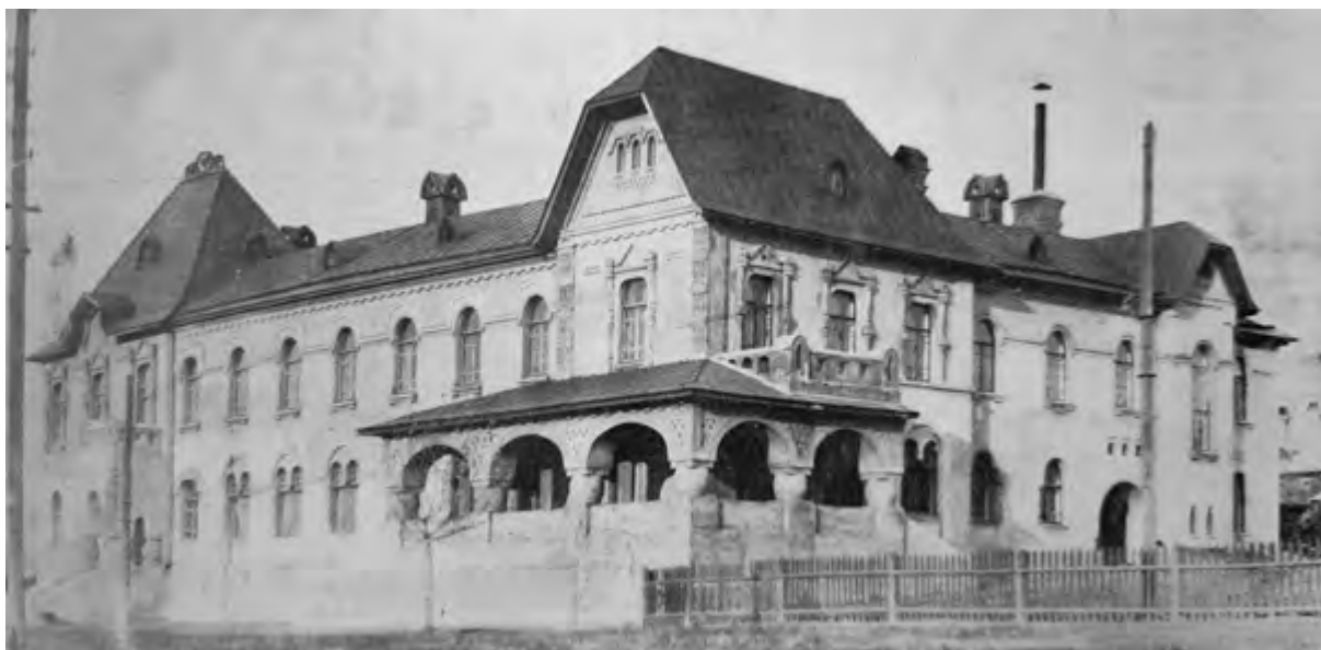
< Рис. 9. Здание дежурных, паровозных и кондукторских бригад на ст. Пограничная КВЖД [5]
