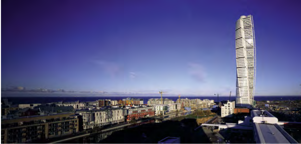
< Рис. 1. Башня «Поворачивающийся торс». Мальмё (Швеция). Архитектор С. Калатрава. 2003–2005 ( https://calatrava.com/ )
