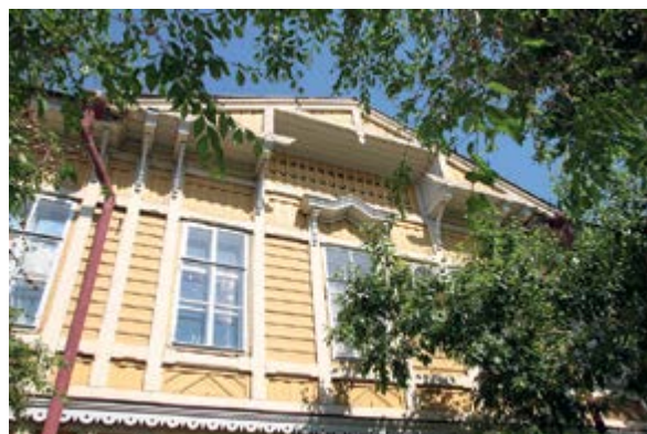
> Рис. 2. Здание почтово-телеграфной конторы в Чите, 1893. Архитектор М. Арнольд. Современное состояние. Вид со стороны ул. Бутина
