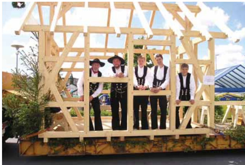
Так выглядит конструкция традиционного фахверка
