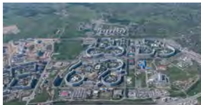
^ Рис. 6. Микрорайон «Солнечный», характерный для II периода строительства (морфотип «Свободная застройка») – URL: fotostrana.ru
