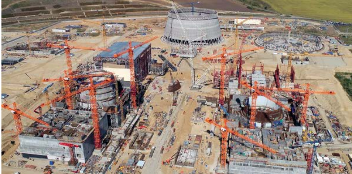
< Рис. 7. Строительство Курской АЭС-2 ( https://www.kommersant.ru/doc/5079615 )
