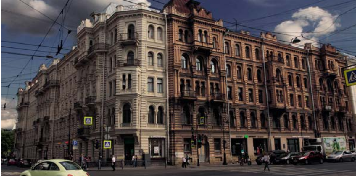
< Доходный дом Мурузи. Санкт-Петербург
