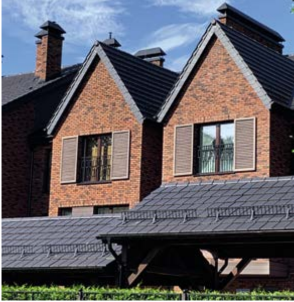
^ Калининград. Блокированные жилые дома. Постройка 2020 года
