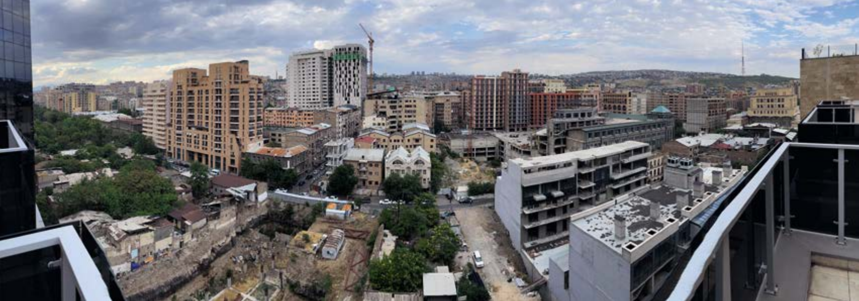
^ Рис. 29. Новый Ереван, исторический центр города. На переднем плане – разрушение исторических вернакулярных кварталов между улицами Арами и Бюзанда и строительство ТРЦ «Старый Ереван». Фото автора, 2021
