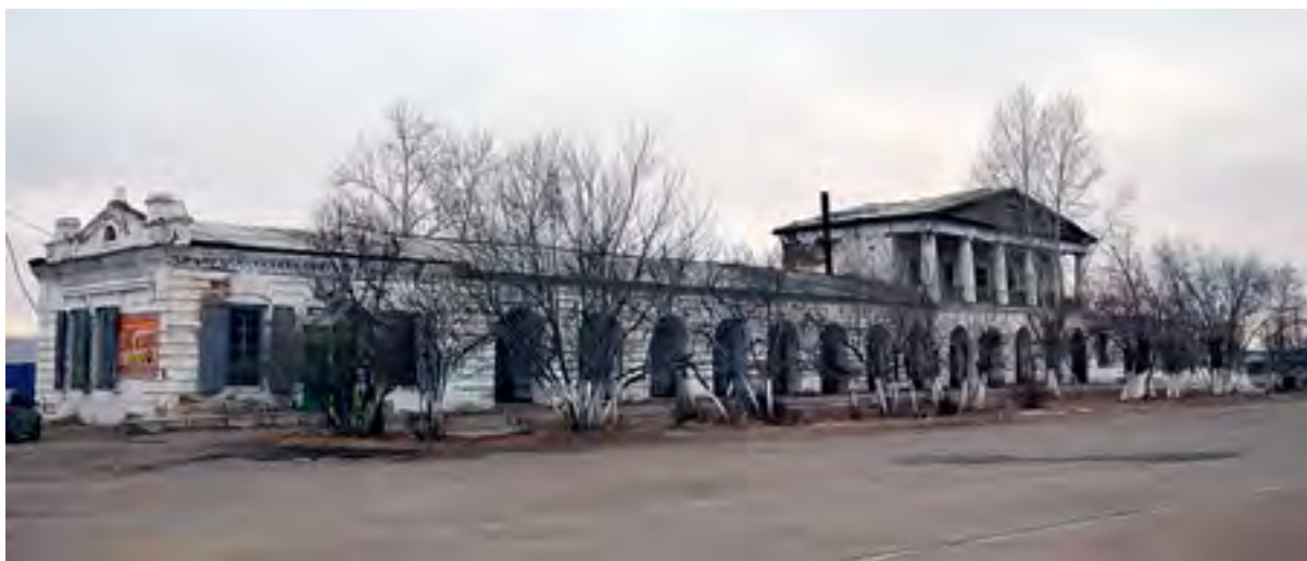
< Рис.19. Гостиный двор. Общий вид здания
