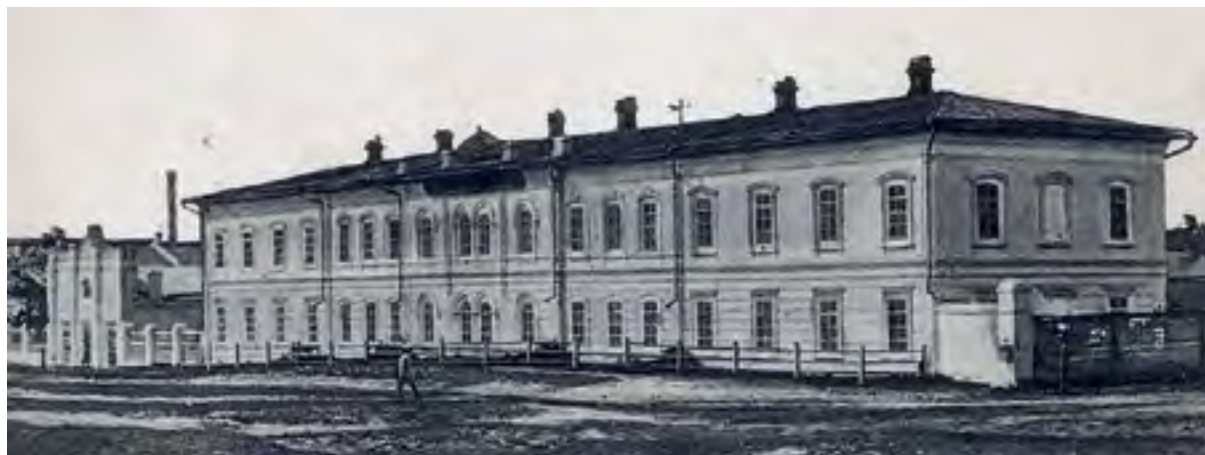
< Рис. 27. Нерчинск. Здание Духовного училища. Реконструкция В. И. Куликовского
