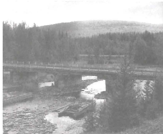
Опоры-ряжи старого моста через Куленгу. 2002 г.
