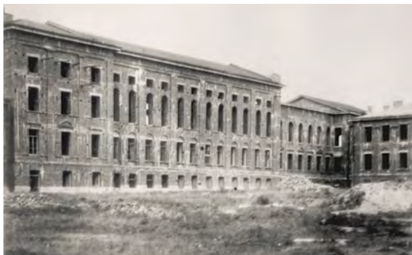
^ Недостроенный главный корпус кадетского училища. Дворовый фасад. Фото 1920-х
