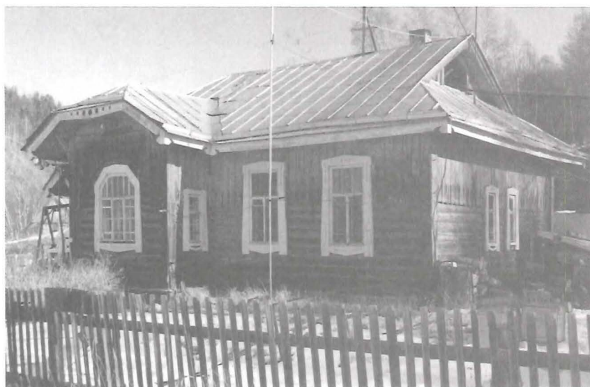
Путевая постройка – полуказарма 2-го пути. 106 км
