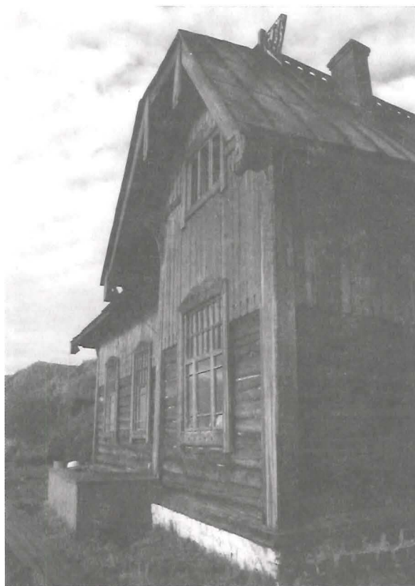
Пассажирское здание станции Култук. 156/157 км
