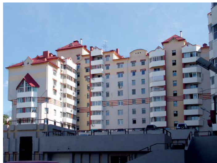
^ Жилой дом, ул. Комсомольская, 96. Дворовый фасад. Архитектурная мастерская «Архстиль». Архитекторы А. С. Ческидов, В. П. Шитова. Фото Н. П. Крадина. 2017
