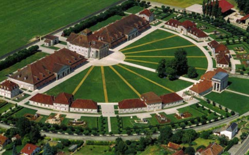
^ Сохранившийся фрагмент поселка солеваров Шо (1771), объект культурного наследия ЮНЕСКО. Клод-Николя Леду свой «социально-утопический» проект намеревался сделать в форме окружности, обнесенной стенами и сухим рвом. Он писал, что даст городу форму «чистую, как солнце в своем круговращении»
