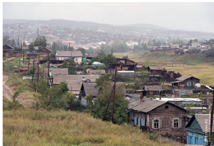
^ Деревянная застройка Кяхты
