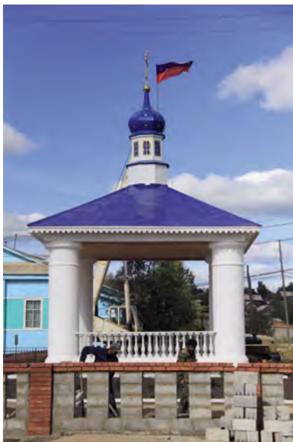
> Современный вид часов- ни после реконструкции
