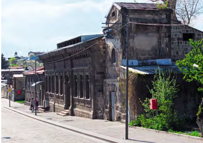
^ «Дом с двойным карнизом» и трансформаторная будка 1950-х гг. – фрагмент вернакулярного ансамбля ул. Руставели
