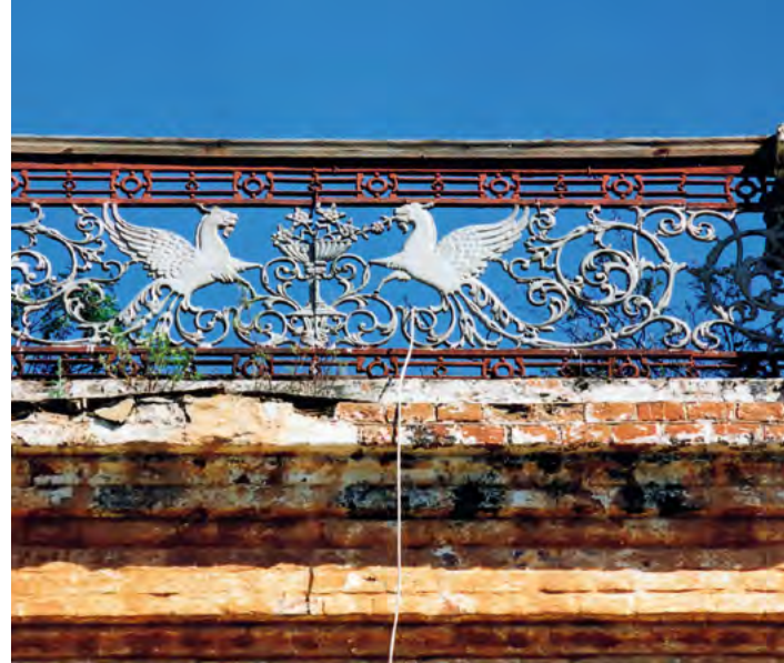
^ Рис.13. Звено ограждения на крыше ТД Андоверова
