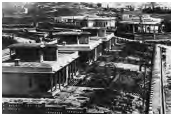
< Рис. 31. Коттеджный поселок «Березки» для высшего административно-технического руководства города и завода. Соцгород Магнитогорск. Архив МУ «Магнитогорский краеведческий музей». Предоставлено Е. В. Конишевой
