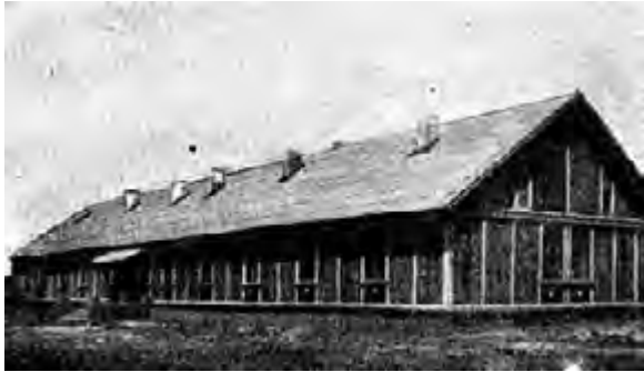
v Рис. 15. Щитовой барак (тип Щ-11) – общежитие для одиноких [13]
