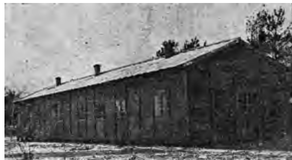
^ Рис. 17. Фанерный (сборно-разборный) барак конструкции инж. Андреевского. Конец 1920-х гг. [10, с. 78-80]
