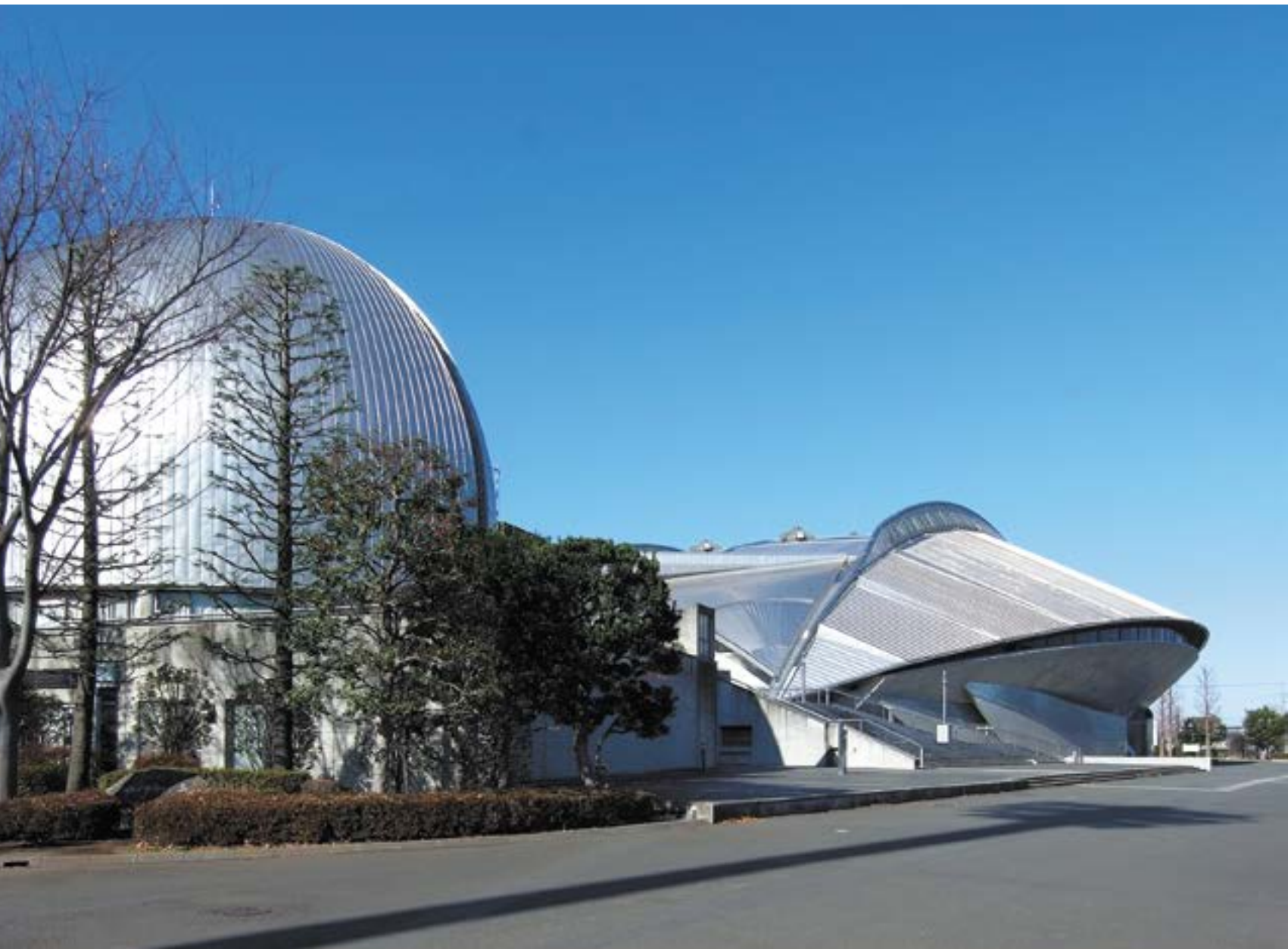
в Спорткомплекс в Фуд- жисава, 1984 г. / Fujisawa Municipal Gymnasium, 1984
