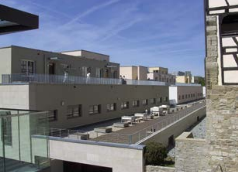
^ Апрель 2011, завершаются отделочные работы в квартирах
