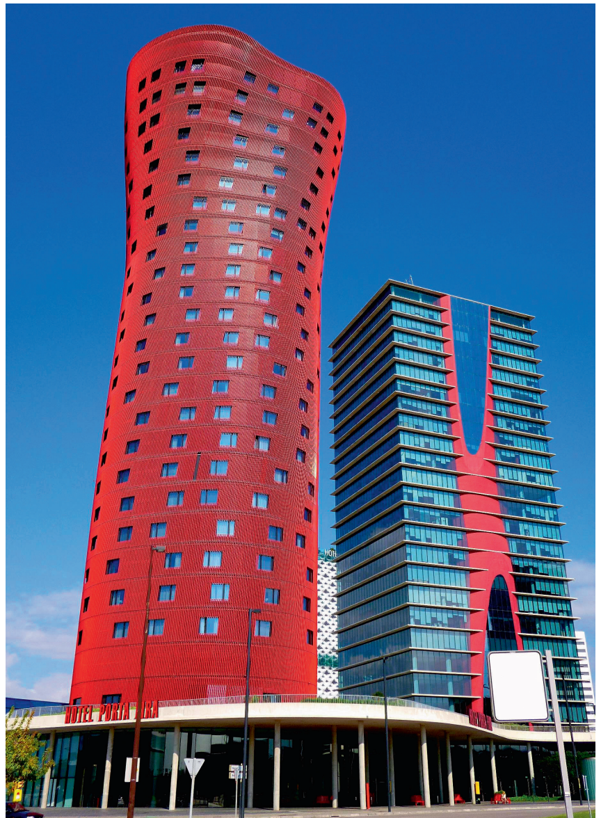
v ОТЕЛЬ «ПОРТО ФИРА (Torres Porta Fira), Барселона, Испания, 2010 / Torres Porta Fira, Barcelona, Spain, 2010
