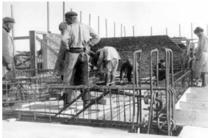
в Рис. 6. Работы по устройству железобетонного каркаса школы Кемеровского рудника. 1927. Из фондов музея «Красная Горка»
