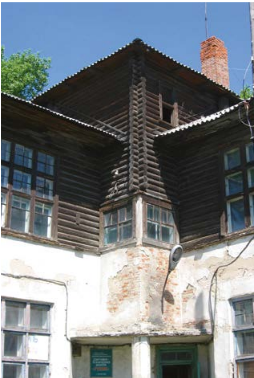
v Рис. 11. Школа Кемеровского рудника. Современное состояние. Фото автора
