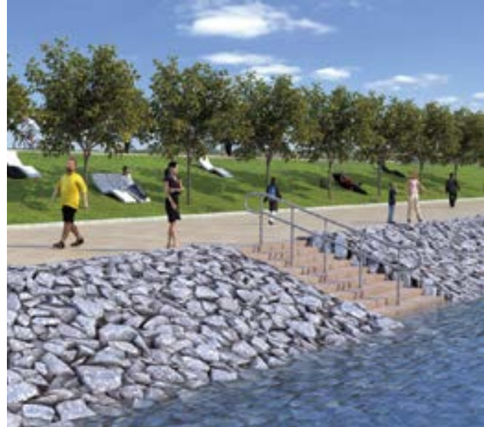
^ Вариант берегоукрепления с откосным профилем и мощением из сортировочного камня
