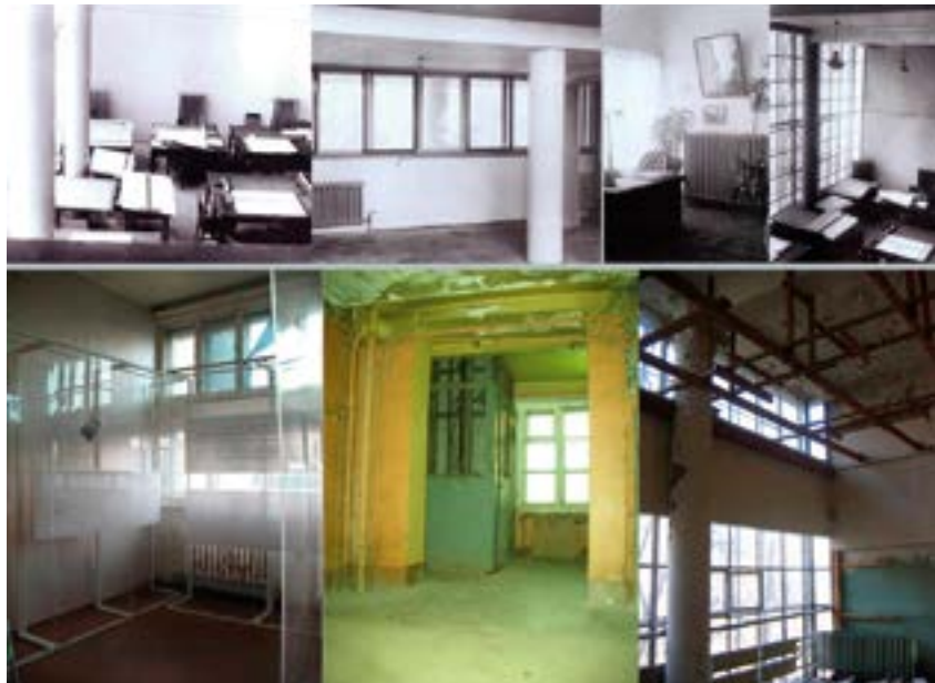
> Интерьеры дома Наркомфина на Новинском бульваре. Начало 1930-х годов и 2011 год. Батареи отопления не сохранились
