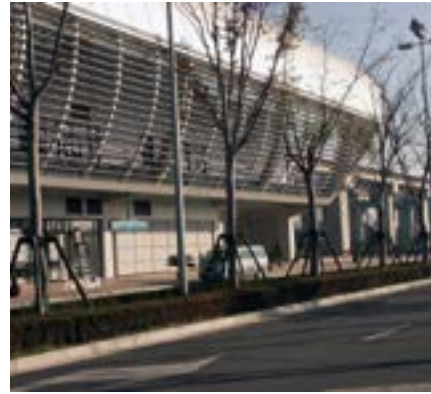
^ Станция и начало эстакады шанхайского скоростного экспресса на магнитной подушке, разгоняющегося до 440 км в час
