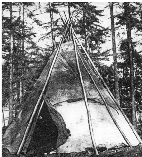
Рис. 9. Вход в чум (отворот мягкой покрывки, эвенки)
