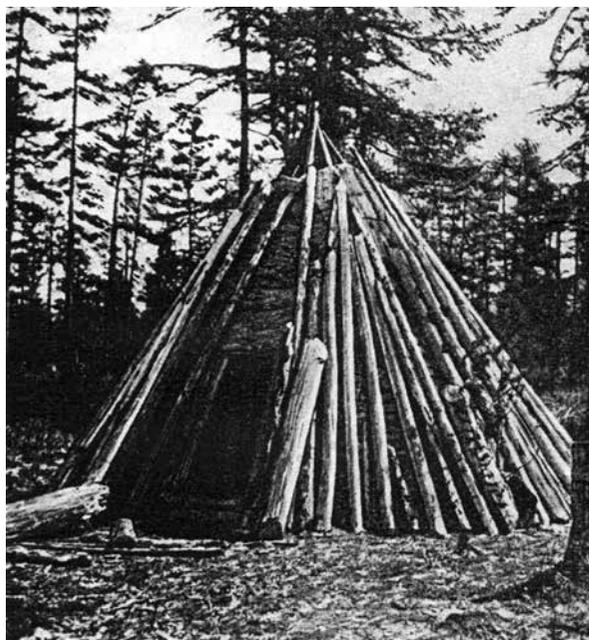
Рис. 8. Зимняя фиксация покрывки чума внешним рядом жердей (эвенки)
