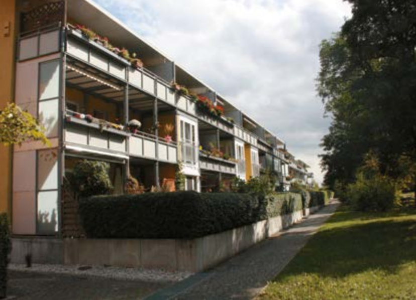
^ Рис. 10. Горбиц. Изменение высотности зданий крупнопанельной застройки («разборка»), реконструкция с помощью современных материалов и повышение качества жилой среды, создание индивидуальных озелененных пространств (приусадебные садики). Фото А. Малько, 2016
